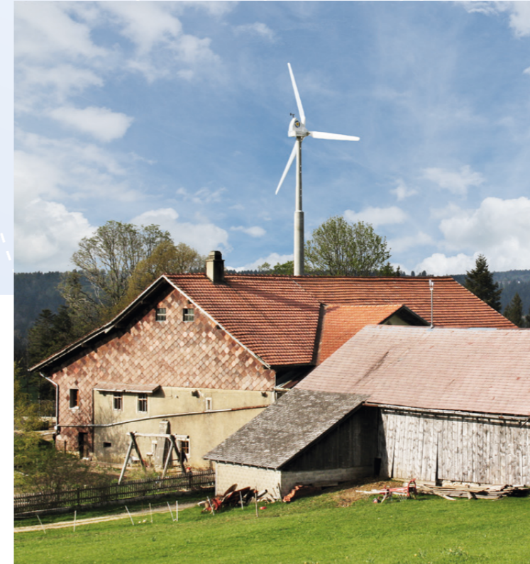
Abbildung 7: Kleinwindanlage bei einem Bauernhof im Schweizer Jura
