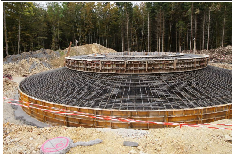
Abb. 4: Fundament einer Grosswindanlage des Windparks Verenafohren (Quelle: Andreas Klatt, Design-Connection).
