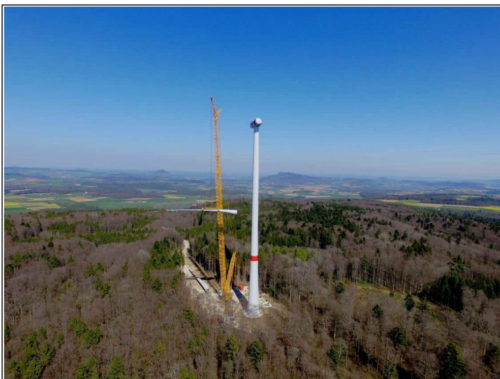
Abb. 5: Errichtung einer Grosswindanlage des Windparks Verenafohren (Quelle: Jens Scherer, DesignConnection).
